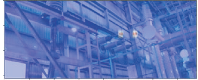
写真4 部分放電源の特定事例
